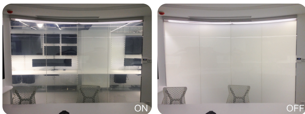
会议室调光玻璃隔断
